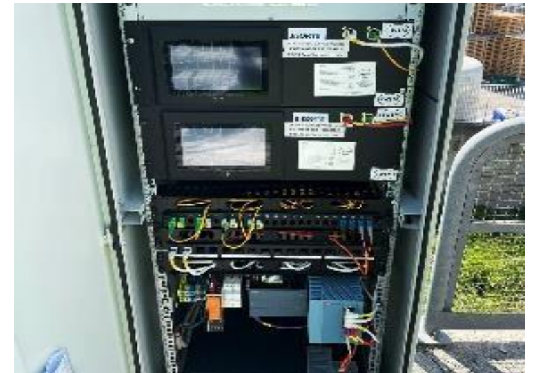
Fase 6: Instalación de dataloggers y dispositivos tecnológicos.
