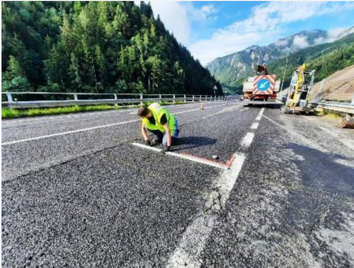
Fase 1: Trazar el contorno de la excavación en el pavimento.
