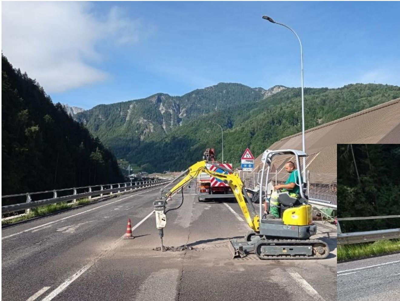
Figura 4: excavación de los orificios que albergan las placas de pesaje y la canalización hasta el borde de la carretera para los conductos de fibra (profundidad de excavación 20 cm)
