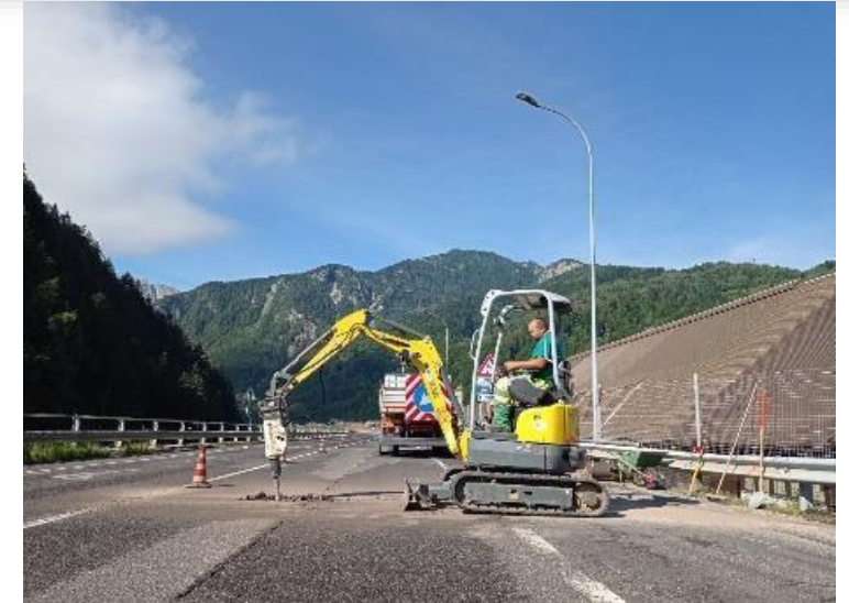
Fase 3: Ejecución de la excavación
