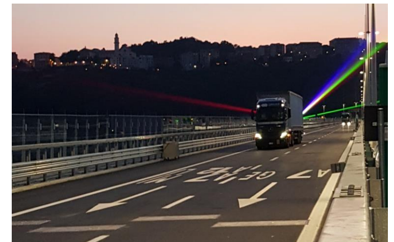
El sistema instalado en funcionamiento
