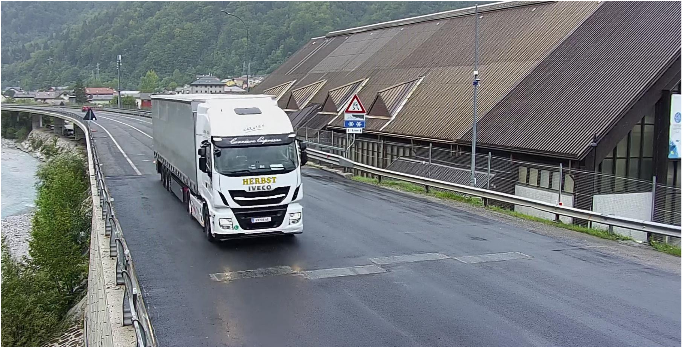
Figura 12: Reapertura de la carretera después de fraguar el mortero (3,5 horas desde el inicio del vertido)
