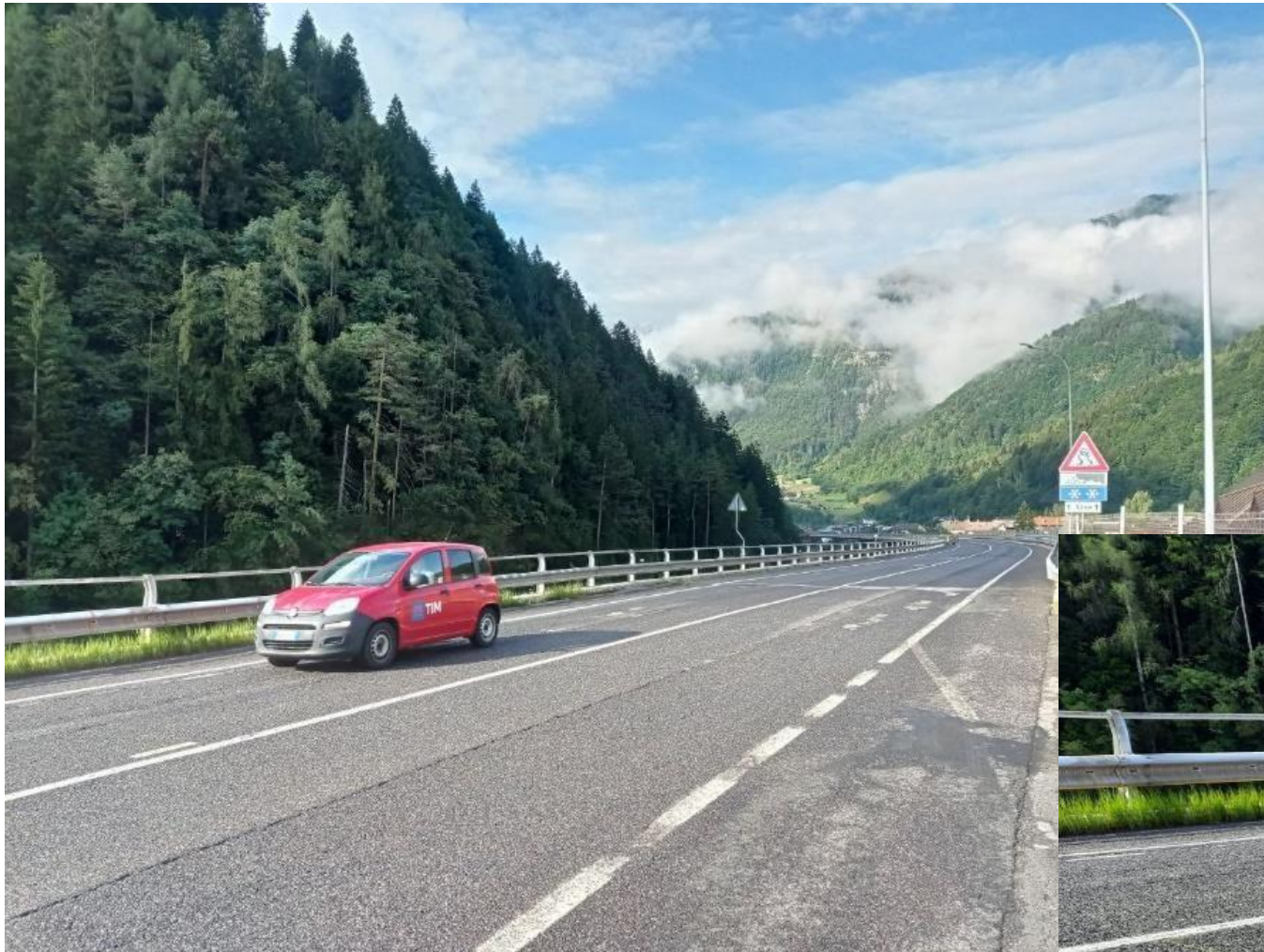
Figura 1: inicio de la instalación de señales de cierre de carreteras
