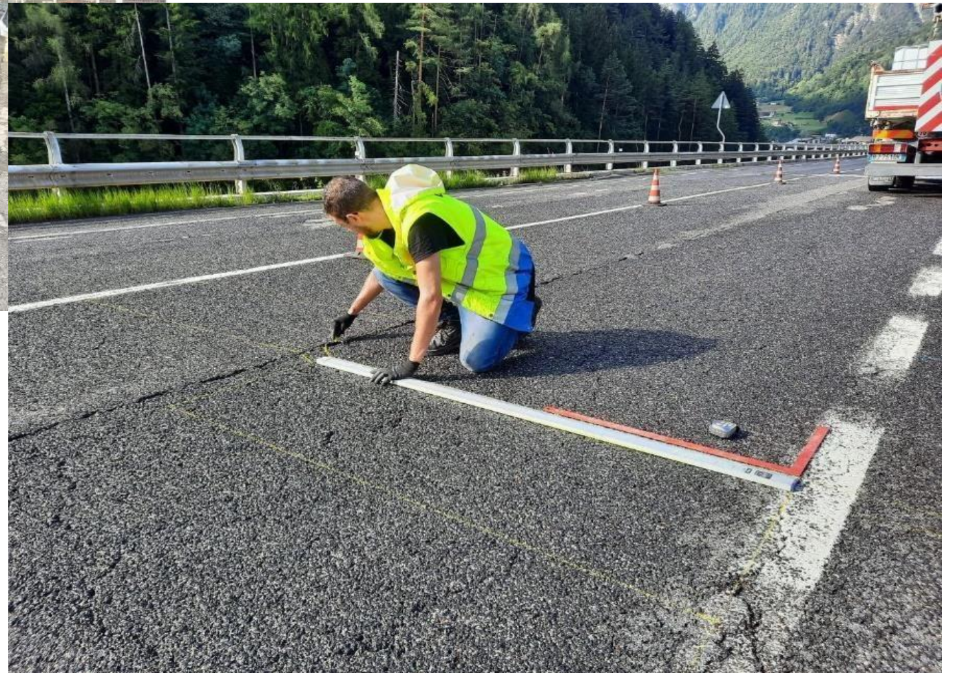
Figura 2: marcación de excavaciones
