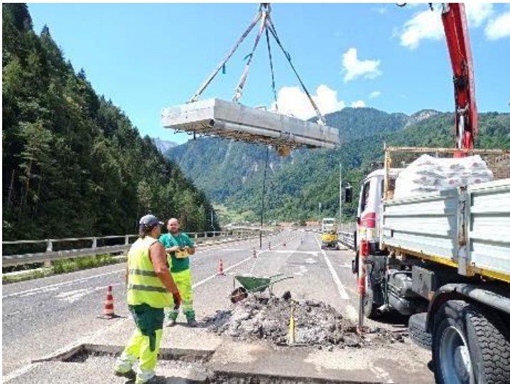
Fase 4: Instalación de elementos prefabricados de hormigón y disposición de conductos.
