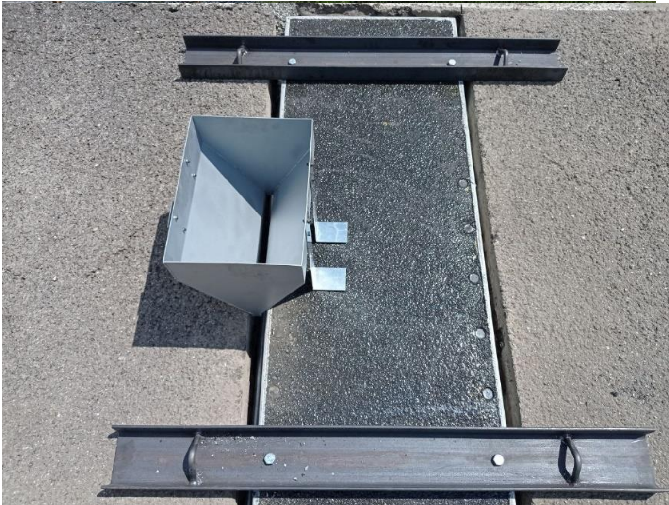
Figura 8: colada de mortero a través de la tolva suministrada por iWiM
