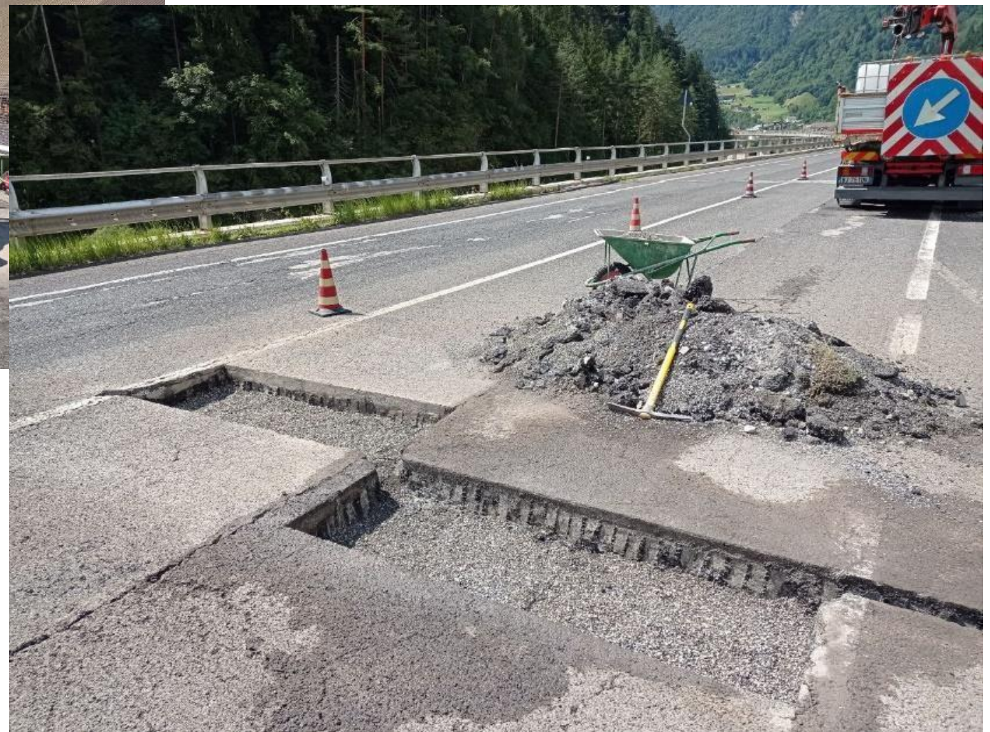
Figura 5: Nivelación del fondo de excavación con grava estabilizadora y eliminación del material retirado
