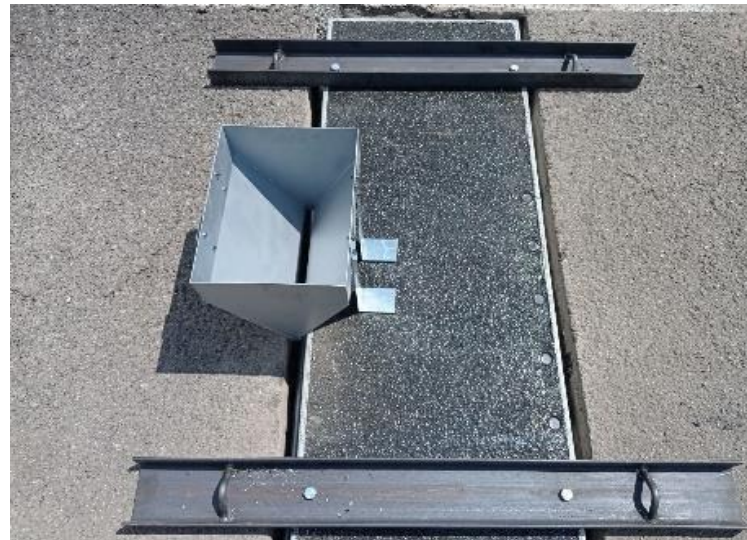
Fase 5: Vertido de mortero de cemento para la fijación de elementos prefabricados.
