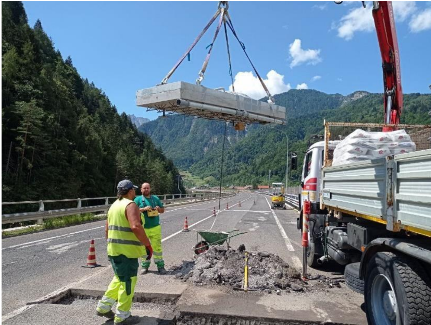
Figura 6,7: instalación con grúa de prefabricados de hormigón armado con placas sensoras pre instaladas
