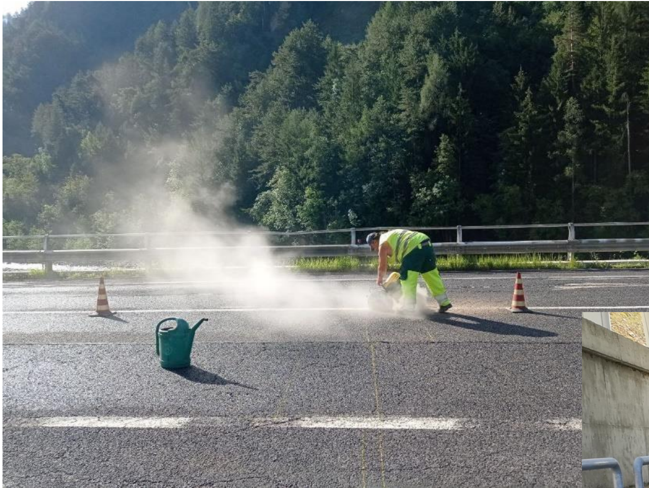
Figura 3,4: corte del pavimento con un cortador de asfalto
