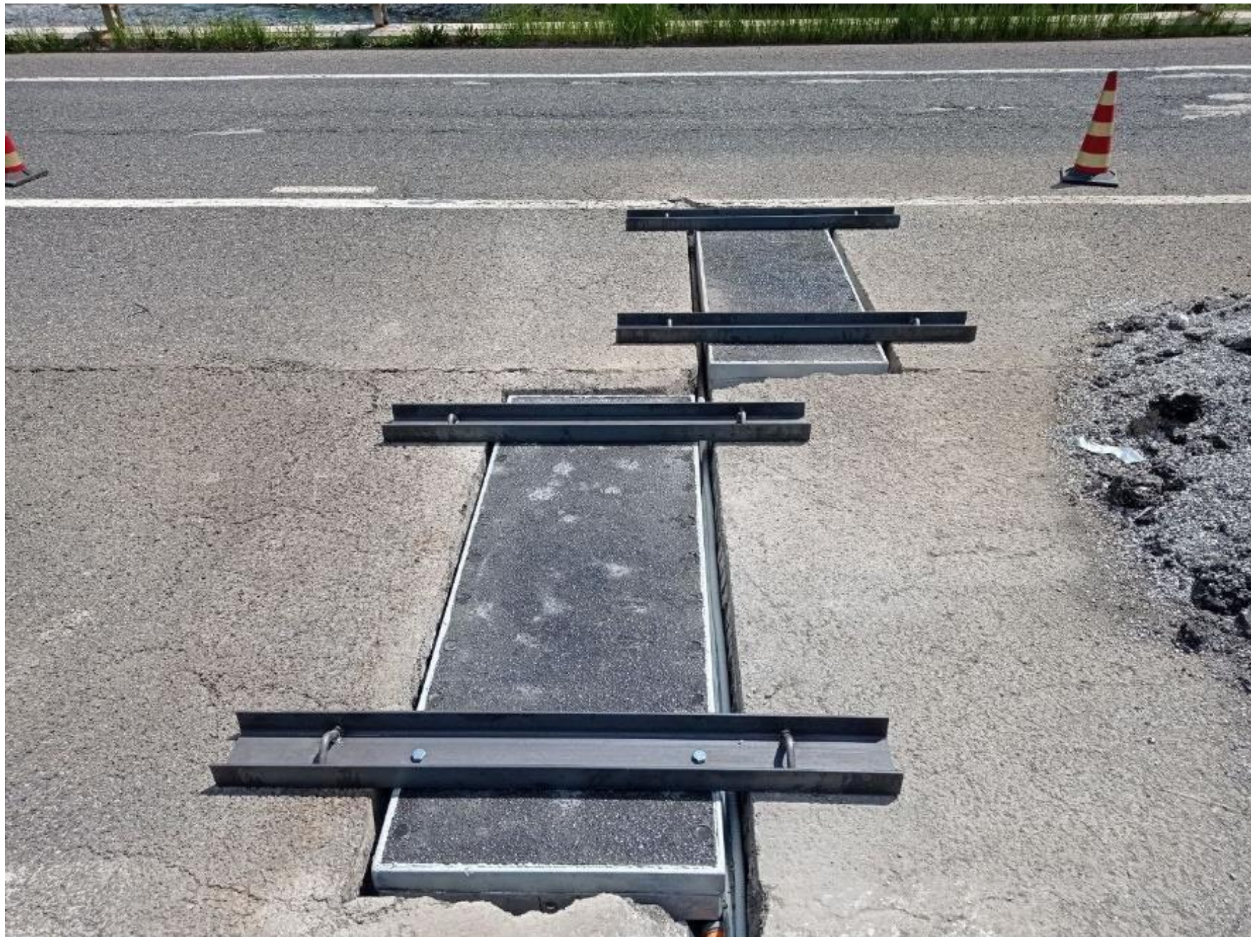
Figura 7: nivelación de prefabricados con vigas de nivelación
