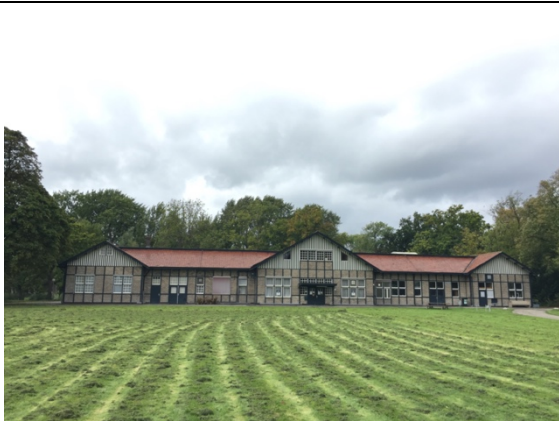
3. Oostgevel, zicht vanaf weide
