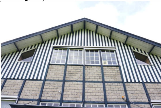
5. Topgevel in oostgevel
