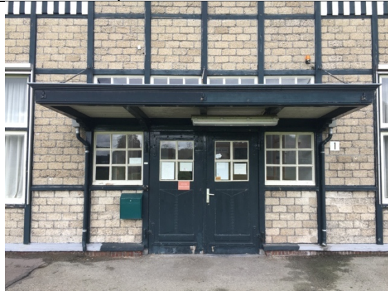
4. Entree in oostgevel
