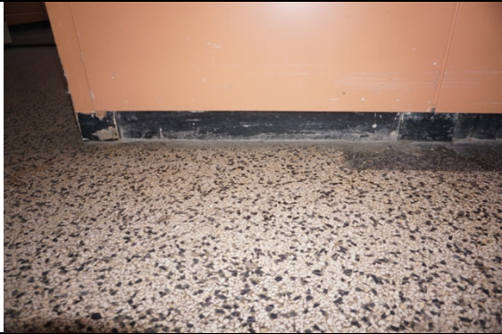
19. Plint in gang en granito vloer
