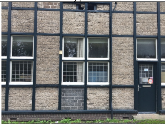
16. Westgevel met vernieuwd deel
