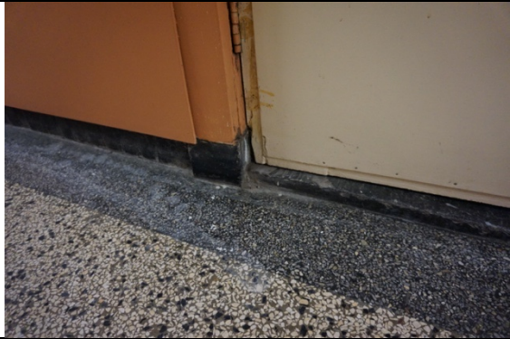
20. Detail neut van deurkozijn gang
