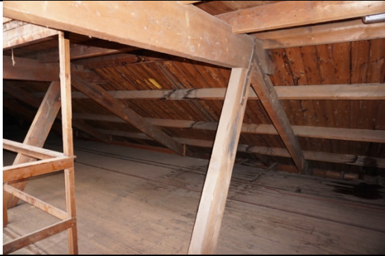
23. Detail van kapconstructie zolder
