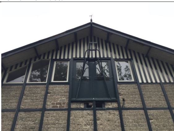
15. Westgevel centrale deel met luik
