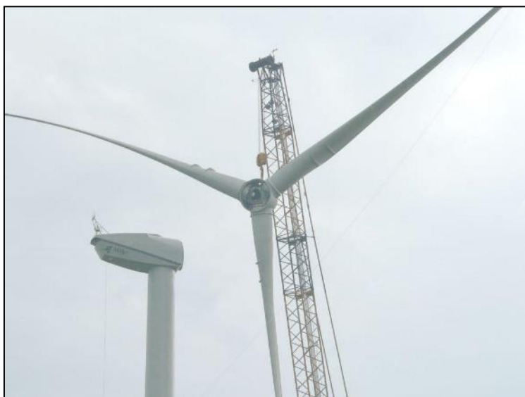
Figure III.4-15 : Montage du rotor d'une éolienne (source : The Wind Power)
