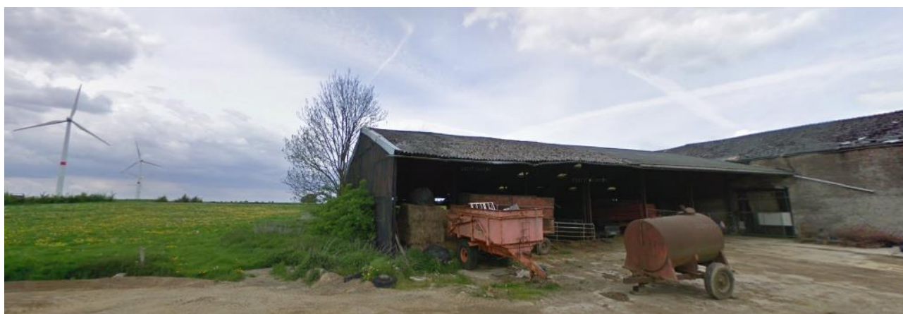
Vue de la façade ouest avant la rénovation et la transformation de la ferme en habitat à logements multiples (mai 2009).
