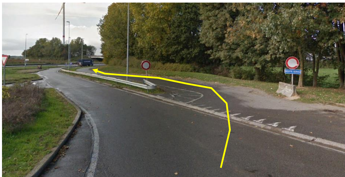
Figure III.4-2 : Sortie de service de l'aire d'Aische-en-Refail (photo #2)
