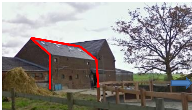
Vue rapprochée de la façade sud-ouest orientée vers les éoliennes
