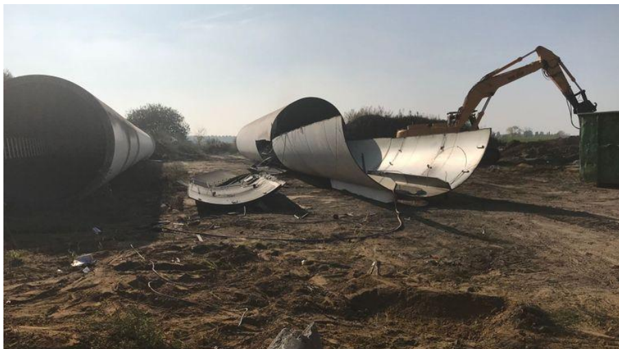
Figure III.4-9 : Découpage du mât d'une éolienne en cours de démantèlement à Perwez (rtbf.be)
