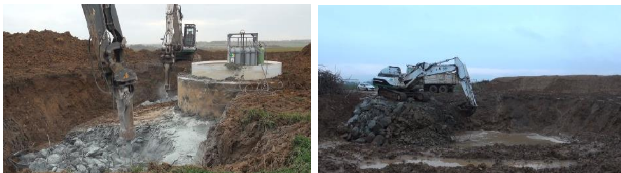
Figure III.4-10 : Démantèlement des fondations d'une éolienne à Criel-sur-Merc (Valorem)
