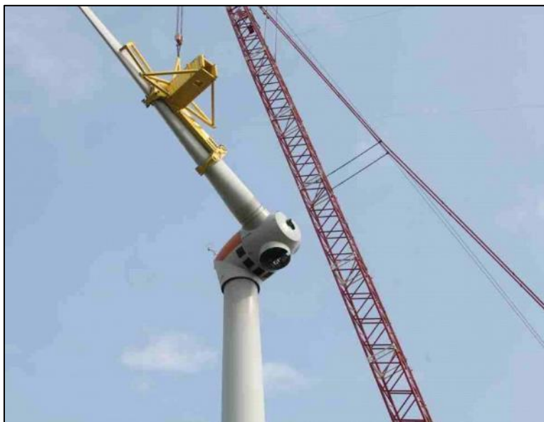
Figure III.4-16 : Montage du rotor d'une éolienne, pale après pale « Single blade installation » (source : Windpower Engineering)
