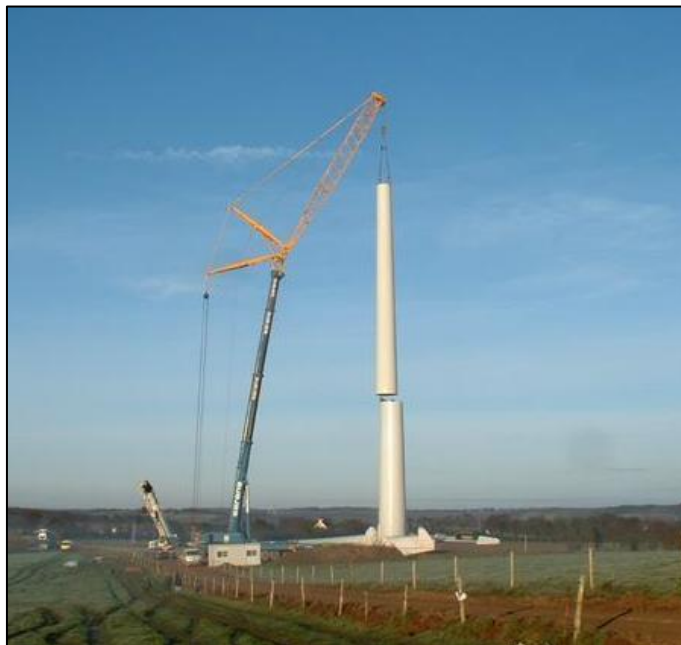
Figure III.4-14 : Érection du mât d'une éolienne (source : Eric Burlot, parc éolien du Haut Corlay, France)
