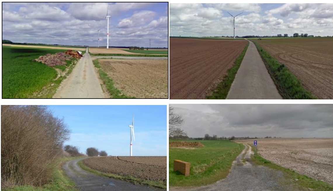
Figure 6 : Illustration des chemins agricoles existants permettant d'accéder aux zones de chantier
