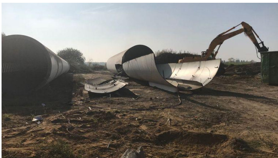
Figure 7 : Découpage du mat d'une éolienne en cours de démantèlement à Perwez (rtbf.be)
