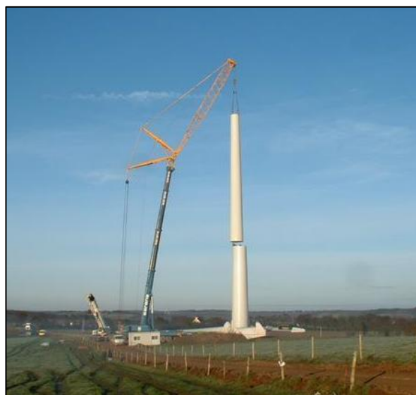
Figure 8 : Construction d'une éolienne (en haut à gauche : mise en place de la fondation, en bas à gauche : assemblage du mât, à droite, mise en place du rotor)
