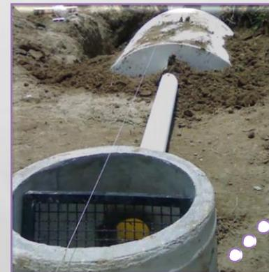
Diseñado para el tratamiento de aguas residuales sanitarias con carga orgánica medianamente alta y con un contenido considerable de sólidos suspendidos y grasas y aceites, (biodegradable).
