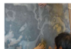
(7) 务必让每片材料紧靠接合，并服贴于墙面，再以手掌压实或使用糊轮在表面施压，使粘贴更紧密。
