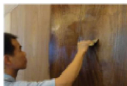
(6) 在预计施工墙面上使用锯齿刮刀均匀涂抹粘合剂，涂上粘合剂后约过10~15分钟，以手指轻触，若不沾手的情况下即可执行张贴施工。
