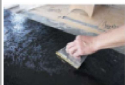
(5) 在石物背面使用锯齿刮刀均匀涂附粘合剂。
