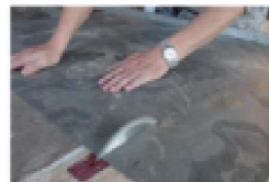
(3) 根据所需要的规格进行切割，也可以用木工用的锯，地毯刀或壁纸刀进行切，以达到所需要规格及准确度为标准，选择合适的工具。
