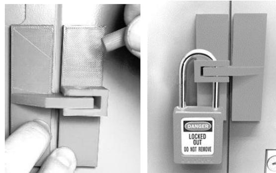
Retire el pasador de alineación de plástico e instale un candado para asegurar todas las posiciones de los interruptores dentro del panel eléctrico.
