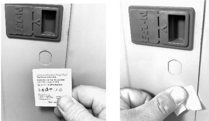
Limpie el polvo y los aceites de la cubierta del panel de disyuntores y la cara de la puerta con una toallita con alcohol isopropílico.
