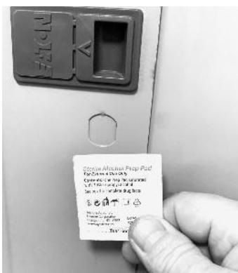
Limpie el polvo y los aceites de las superficies de montaje con una toallita con alcohol isopropílico.
