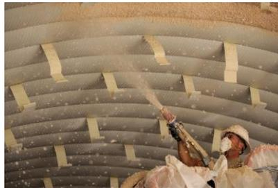
A este tipo de construcción se le puede suministrar **AISLAMIENTO TÉRMICO Y ACÚSTICO** para mayor confort, así como la facilidad de incluir muros divisorios, acabados e instalaciones hidráulicas, sanitarias y eléctricas sin problemas
