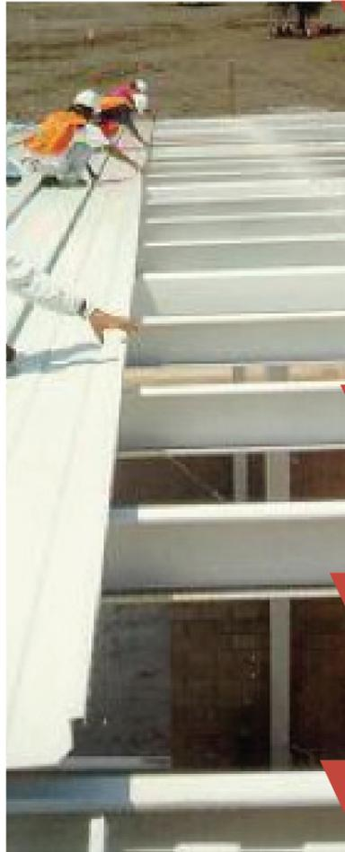
Al sujetar la cubierta con anclas ocultas, se evitan perforaciones en la superficie expuesta
