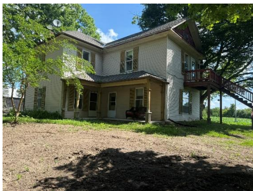
Duplex Exterior - Existing
