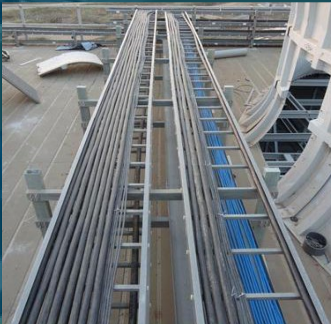
Cable Tray & Cable Ladder
