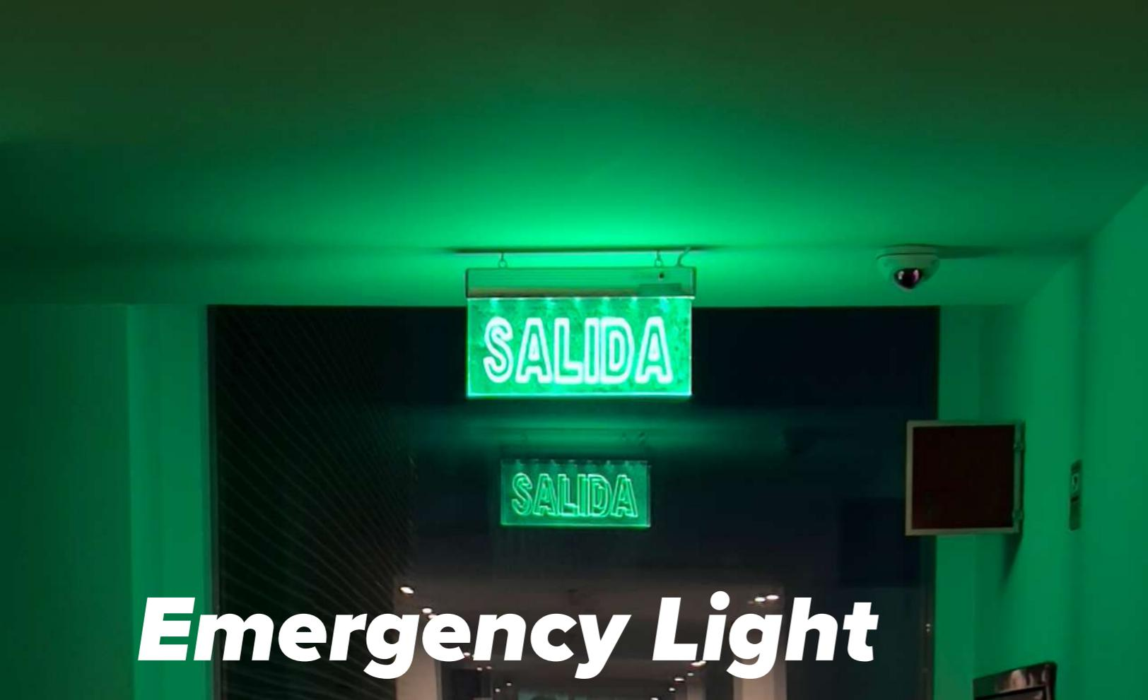
**Almacenan energía en sus baterías y emiten una iluminación constante, clara y brillante en momentos de desconexión eléctrica.**
