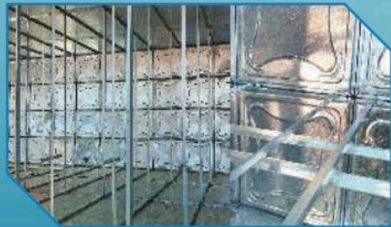
Modüler Sistem Depo İçi Gergi Görünüşü Modular System Storage Inner Joints Appearance
