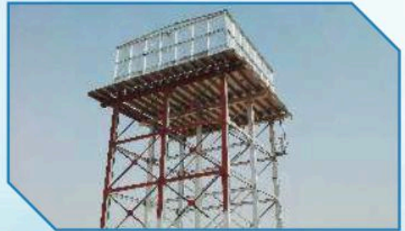
Kerkük / Halica Su Deposu (İRAK) - 266 ton Kirkuk/ Halica Water Tank (İRAK) - 266 ton
