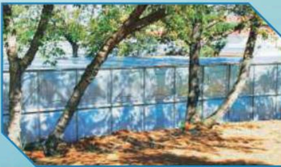
Ankara / EDOK Komutanlığı Su Deposu (TÜRKİYE) - 130 ton Ankara / EDOK Military Base Water Tank (TURKEY) - 170 ton
