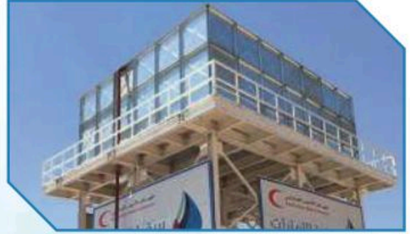
Zaho/ Kamp Kazya Su Deposu (İRAK) - 229 ton Zahoor / Camp Kazy Water Tank (İRAK) - 229 ton
