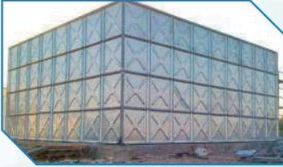
Bağdat / Yangın Su Depoları (İRAK) - 500 ton Baghdad / Fire Water Tanks (İRAQ) - 500 ton
