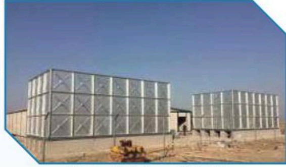
Erbil / Havaalanı Su Deposu (İRAK) - 152 ton Erbil / Airport Water Tank (İRAQ) - 152 ton
