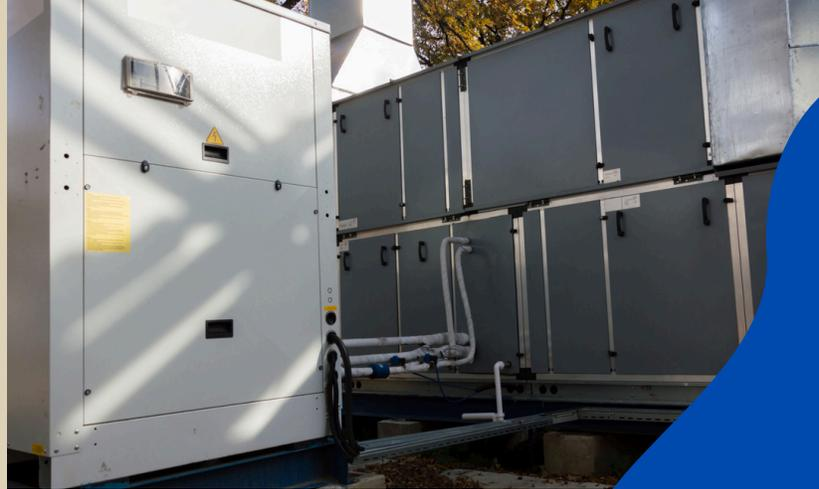
El flujo de aire está equilibrado para evitar el secado localizado o la condensación, mientras que el control inteligente del punto de rocío y del recalentamiento mantienen una humedad estable durante los cambios estacionales.
