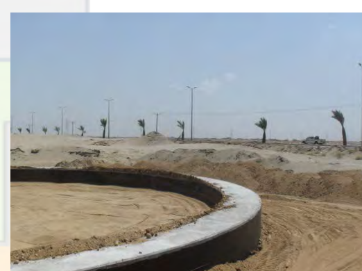
الأساس خزان المياه - WATER TANK FOUNDATIONS
