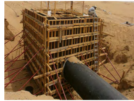
غرف التفتيش و الصمامات - MANHOLES & VALVE CHAMBERS
