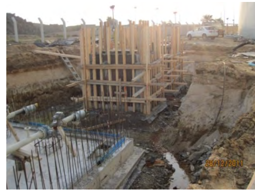
غرف التفتيش و الصمامات - MANHOLES & VALVE CHAMBERS
