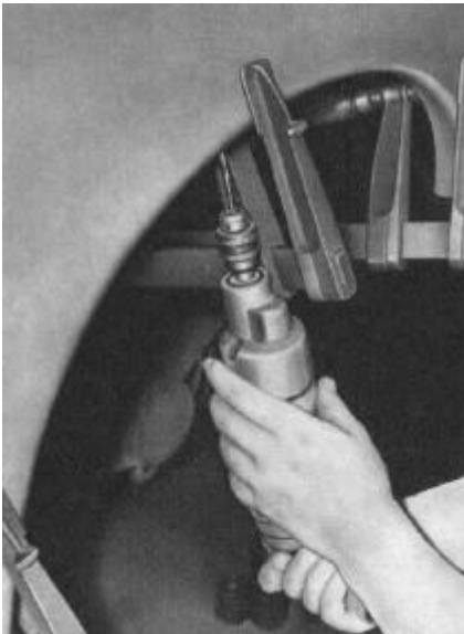
Bild K 16. Nietlöcher bohren
