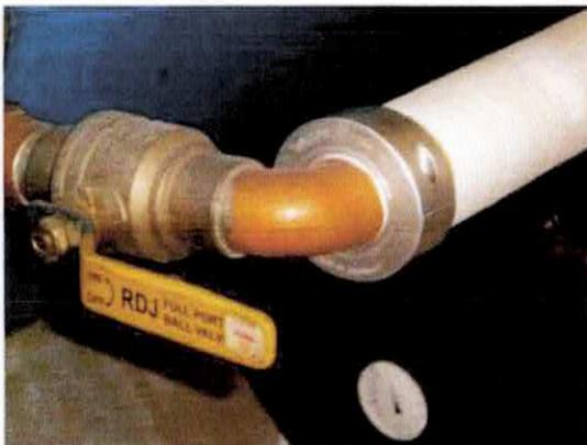
Set ambos del anillo se reduce a la parte preparada de la tuberia. Una flecha asegurada en el anillo es eguro en la direccion del flujo.
