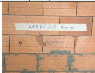
Foto 02 – Ensaio de Impacto de Corpo Duro - Ruptura do bloco
