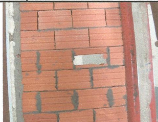
Foto 01 – Ensaio de Impacto de Corpo Mole - Ruptura do bloco
