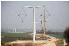
T bar Pylons
