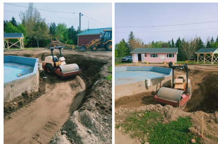
Travaux de compactage
