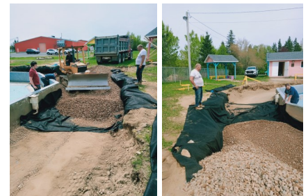
Pose de géotextile et mise en œuvre du concassé
