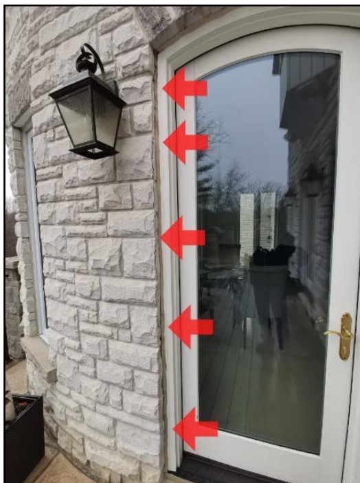
53. Spalling
