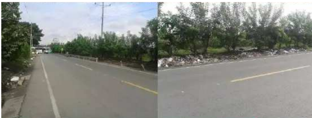
Figura 110. Residuos sólidos en ambos lados de la vía salida al ingenio Mayagüez
