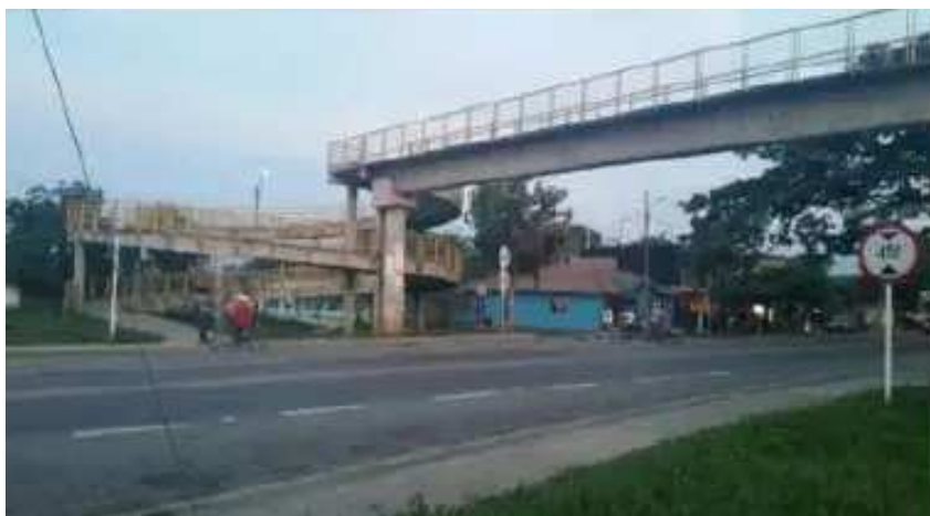
Figura 126. Puente Peatonal ubicado en la Cabecera municipal
