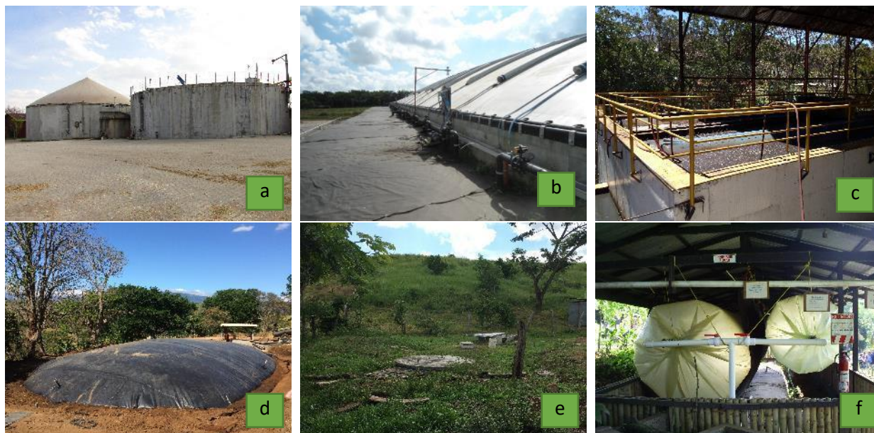
Imagen 29. Fotografías de diferentes tipos de biodigestores. a) biodigestor mesofílico de mezcla completa de dos fases (Alemania), b) Biodigestor de contacto para aguas de la industria de la palma aceitera en Costa Rica, c) biodigestor UASB tratando aguas mieles de la industria del café en Costa Rica, d) biodigestor de laguna cubierta de 900 m 3 en una granja de cerdos en Costa Rica, e) biodigestor domestico de domo fijo nicaragüense, en Nicaragua, f) icónico biodigestor flexible, popularmente conocido como bolsa con la adición de reservorios flotantes en la Universidad EARTH en Costa Rica.
