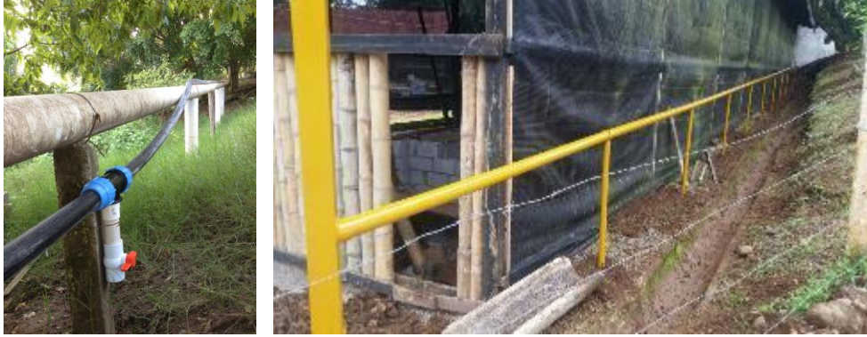
Imagen 8. Ejemplo de instalaciones de biogás realizadas correctamente. a) corresponde a biogás conducido en poliducto (polietileno) en 1"Ø con un punto de desfogue. b) corresponde a un alineación de biogás en tubería en PVC en 2' Ø', con soportes permitiendo una correcta alineación.
