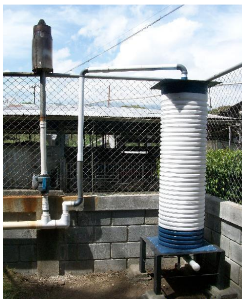
Imagen 11. Ejemplo de un filtro utilizando el concepto de adsorción utilizando sulfatreat, instalado en una granja porcina en Costa Rica por la empresa Viogaz.
