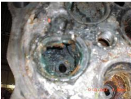
Imagen 10. Daño evidente en los cabezotes de un motor, por la falta de filtración del biogás.
