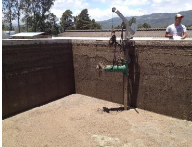
Imagen 8. Tanque de recepción de aguas residuales en una granja de cerdo, con un equipo de agitación.
