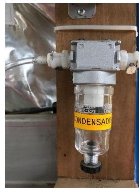
Imagen 45. Deshidratador de biogás, previo a su envío a un medidor de volumen de biogás. Fuente: (Instituto Costarricense de Electricidad, 2018)
