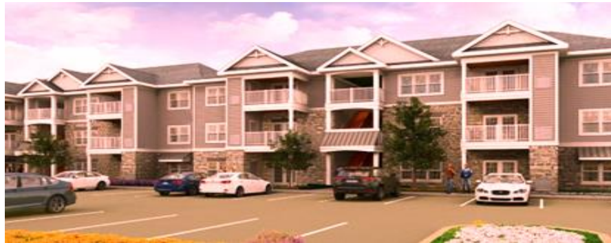
Resim 7.1. Binaların balkonlarından ve camlarından otoparkın görünürlüğü sağlanmaktadır.
