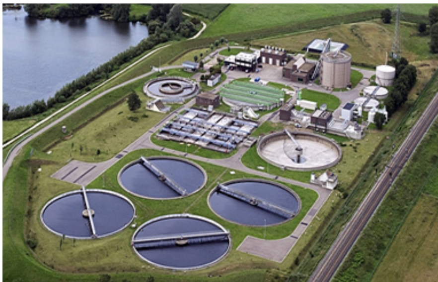
Slika 3. Postrojenje za prečišćavanje otpadnih voda
