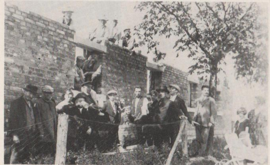
Beim Bau der Turnhalle im Jahre 1930
