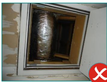
1 : Trappe mal positionnée par rapport aux conduits (accès bloqué par le conduit)
