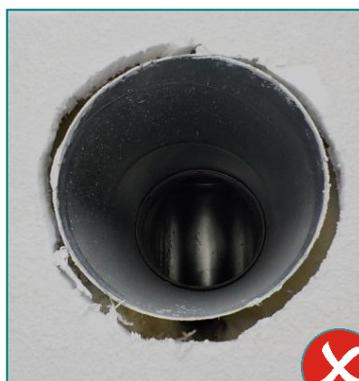
2 : Absence de dispositif de raccordement
