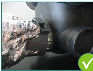
2 : Raccordements correctement réalisés avec colliers de serrage
