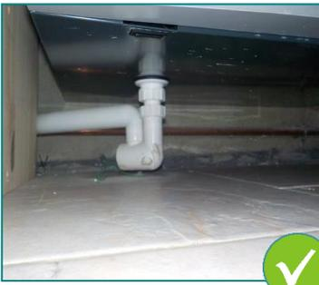
1 : Évacuation des condensats correctement réalisée
