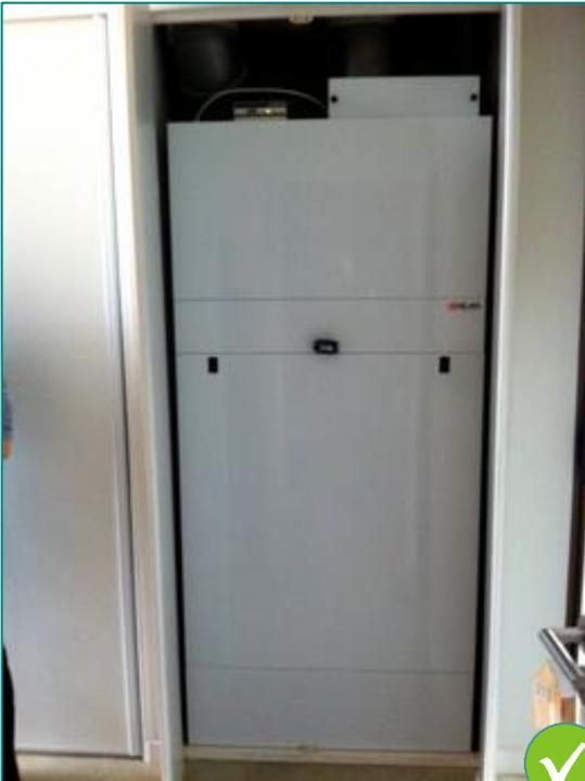
1 : Caisson de ventilation double flux installé dans le volume chauffé
