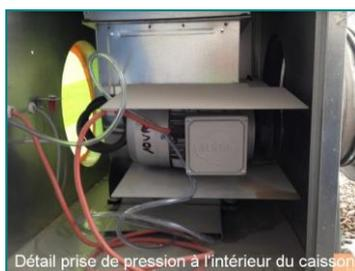
2 : Prise de pression depuis l'intérieur d'un caisson de ventilation
