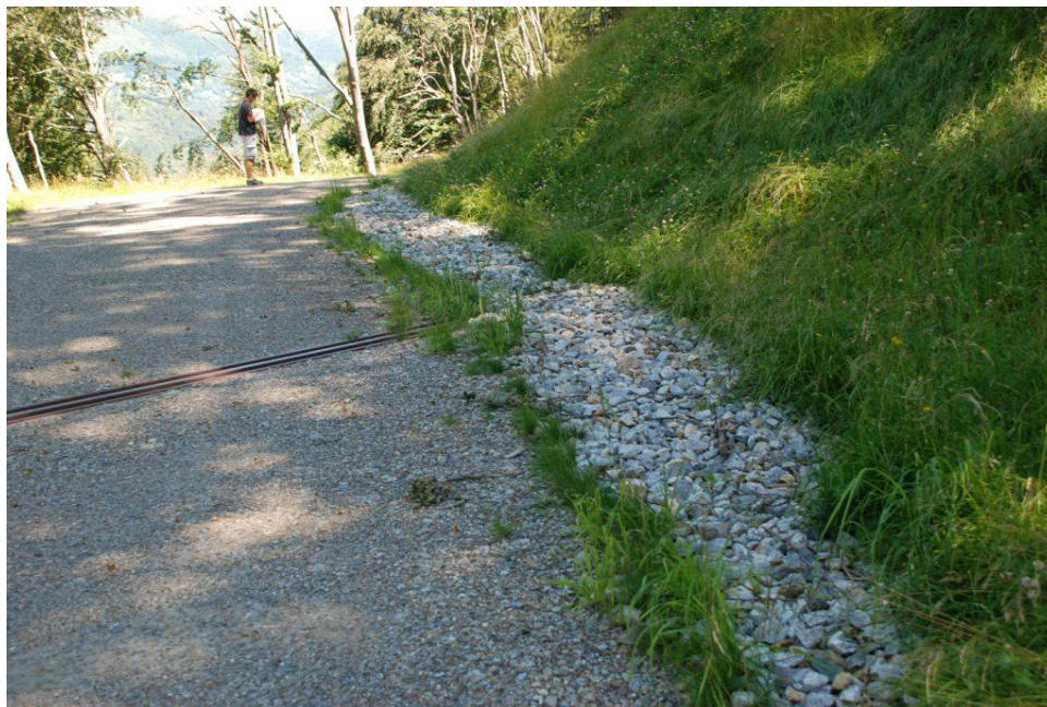
Figura 14: Evacuazione delle acque con trincea drenante
