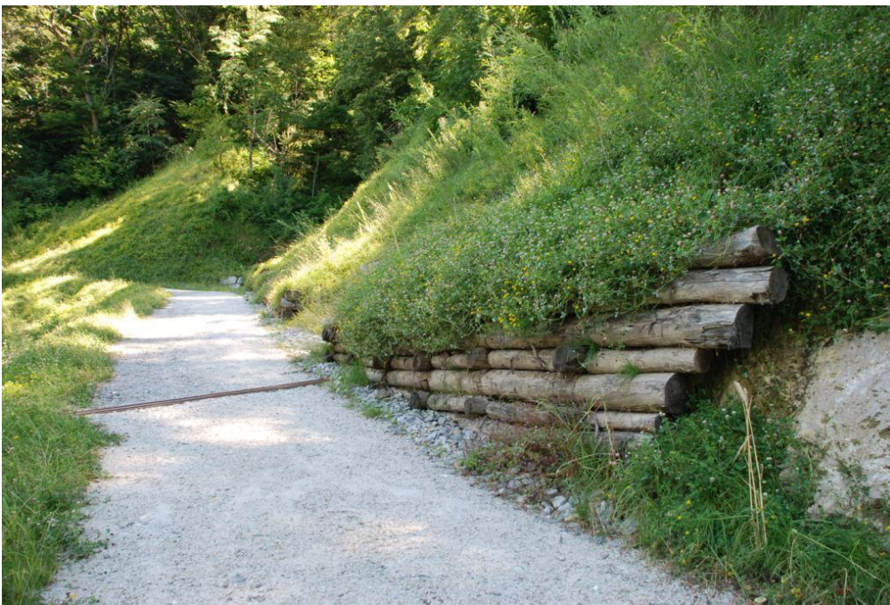
Figura 11: Strada sterrata prevista con cassone in legno
