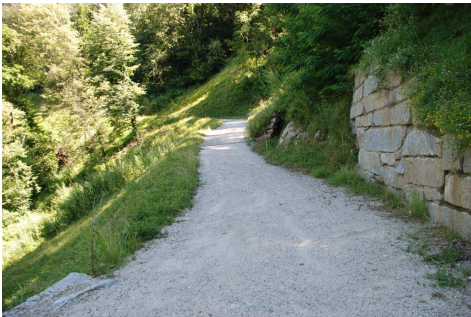
Figura 12: Strada sterrata prevista con muro in moloni
