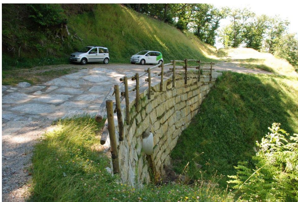
Figura 15: Attraversamenti dei riali a carattere temporaneo travacconi
