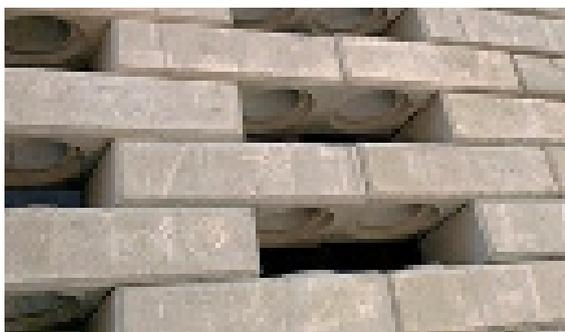
La celosía modular actúa como envolvente permeable, regulando la luz y la ventilación natural, y reforzando la relación interior– exterior.
