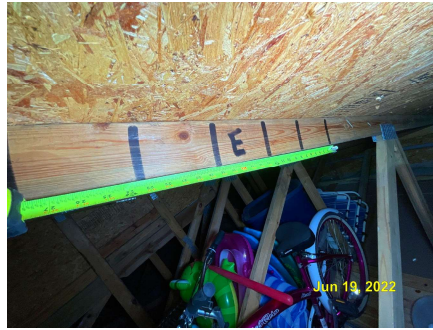
6 Inch Spacing on Edge
