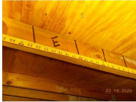
6 Inch Spacing on Edge
