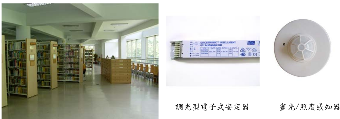
圖 4.17 自然採光運用與晝光/調光的互補設計
