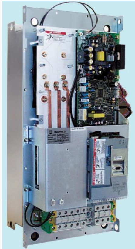
ပုံ ၄၆.၃ (က) ပြောင်းလဲ ဖရီကွင်စီ AC motor drive တစ်ခု၏ အတွင်းပိုင်း
