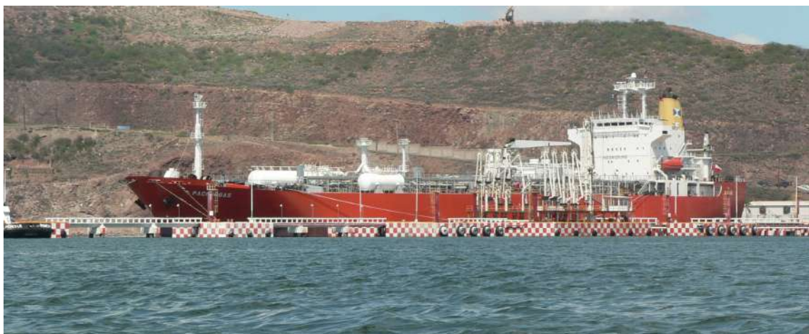
Figura I.1.3. Vista del muelle de PEMEX, actualmente en operación.
