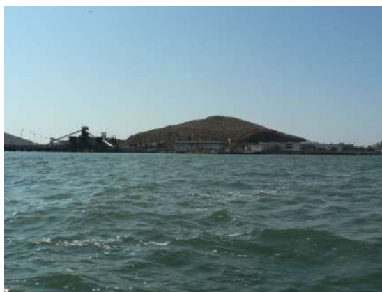
Figura IV.10.3. Estación 02, en la boca de acceso al puerto de Topolobampo
