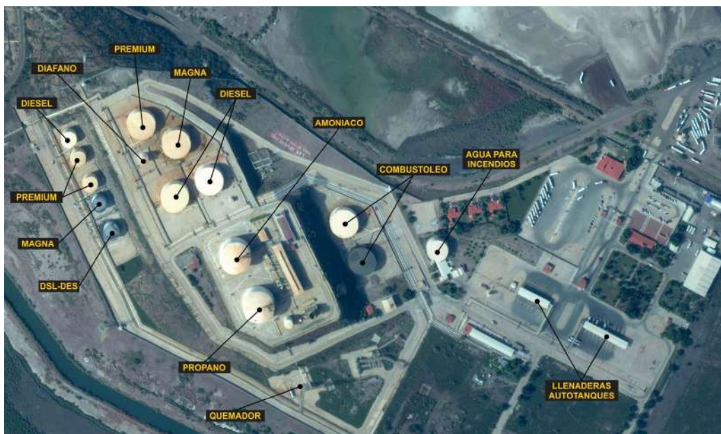
Figura II.2.5. Instalaciones de PEMEX colindantes con el predio.
