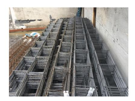
Se coloca entre los muros para evitar grietas, y sirve como refuerzo horizontal para los muros de mampostería reforzados; la escalerilla también se puede colocar cada dos hiladas (40 cm).
