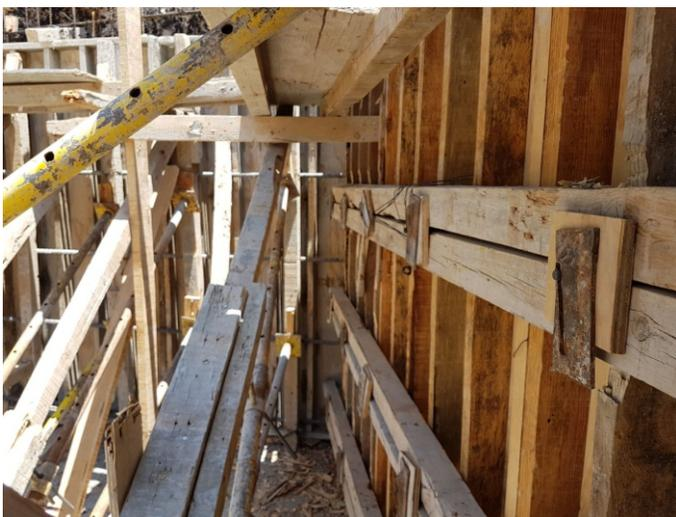
Impide que la cimbra se abra. Capacidad de carga= 3,000lbs, = **1,350kg**. Se usan dos por tirante y son totalmente reusables. Peso= 0.350kg. Están fabricados de acero de alta resistencia, lo que permite mayor vida útil.
