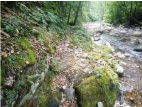
Img. 5: Vecchio canale di adduzione alla centralina
