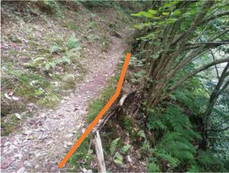
Sostituzione francobordo sul alto a valle
