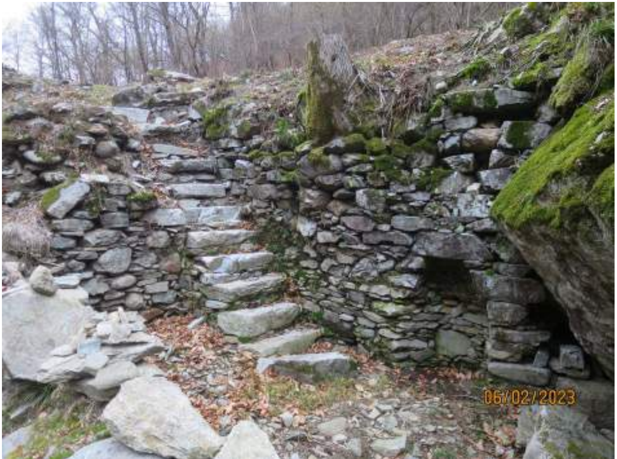
La scala di pietra e la nicchia all'interno della qualchiera, riemersi grazie a una rimozione preliminare del materiale crollato all'interno dell'edificio.
