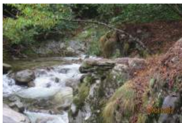
Il frammento di un appoggio murario della passerella
