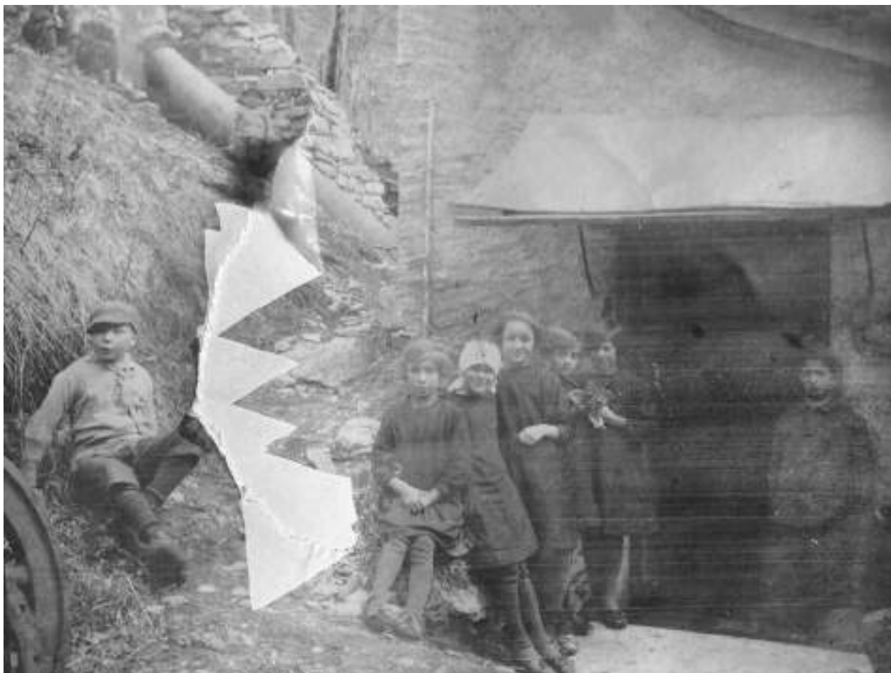
La fotografia del 1932 che ritrae alcuni bambini della scuola obbligatoria di Medeglia in visita alla centrale. In primo piano, sulla sinistra, alcune parti dei macchinari necessari per la produzione di energia elettrica.
