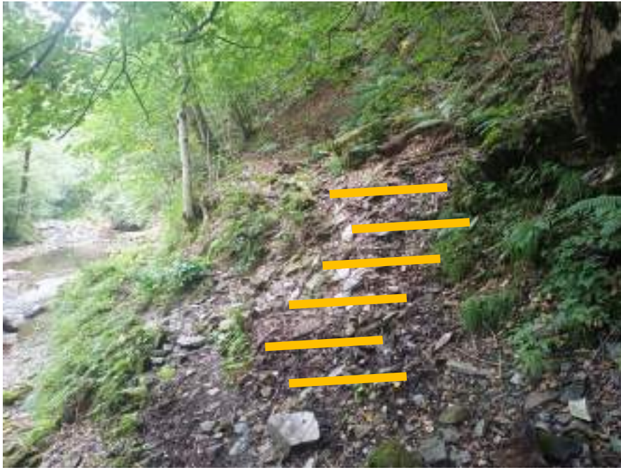
Ripristino tracciato originale e formazione scalinata
