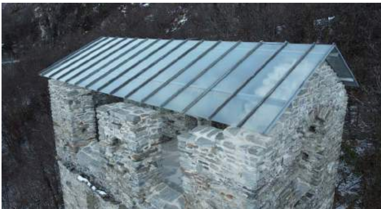
La copertura in ferro e vetro della Torre di Pala a San Vittore, nel Canton Grigioni.
