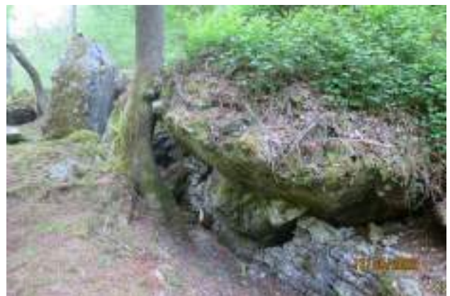
Muri del canale in prossimità dell'inizio della galleria
