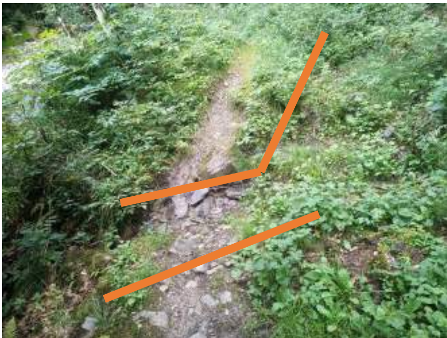
Posa due canalette tagliacqua e canaletta a monte
