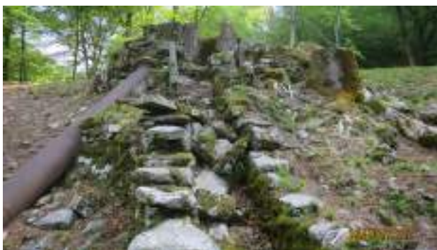
Il canale di deflusso parallelo alla condotta forzata
