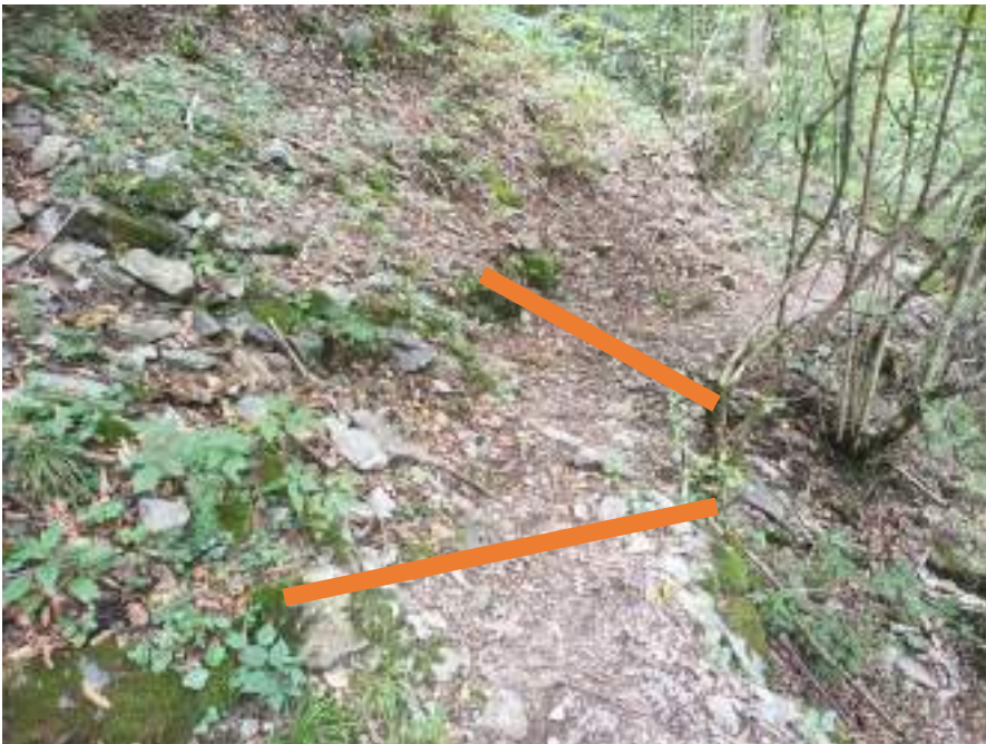
Posa due canalette tagliacqua
