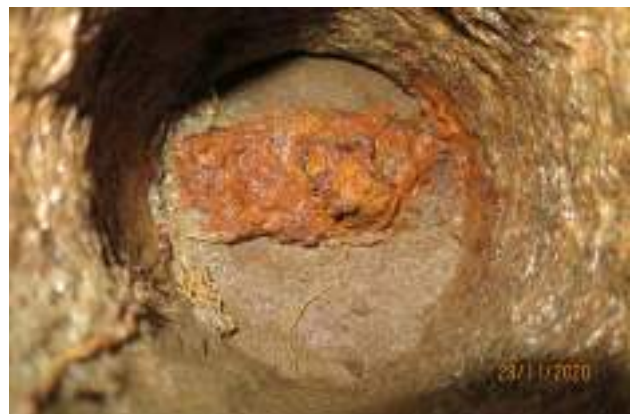
La macina dell'antico mulino giace sopra il palmento... Nel foro la nottola che collegava l'albero alla macina
