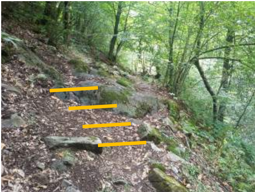
Posa scalini per superamento affioramento roccioso scivoloso
