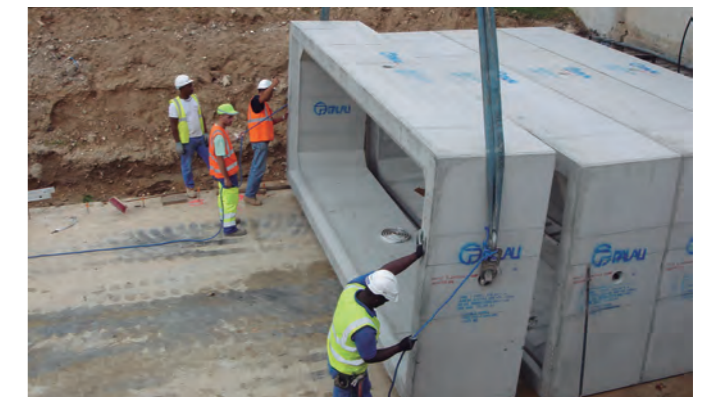
Colocación del producto acabado
