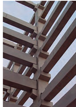
Ejemplo de columnas con muchas ménsulas
