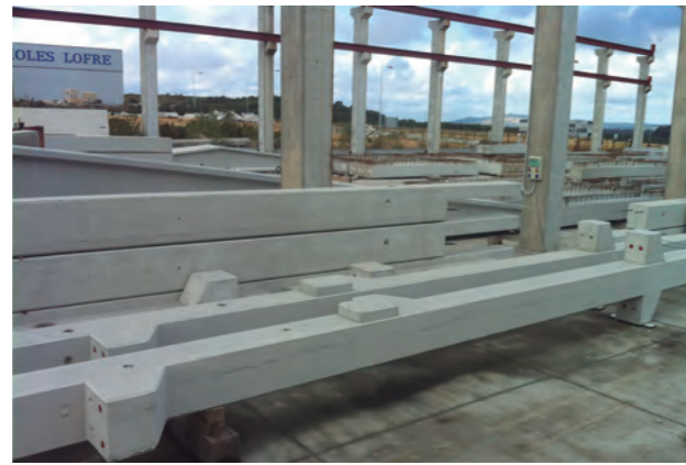
Columna con ménsulas
