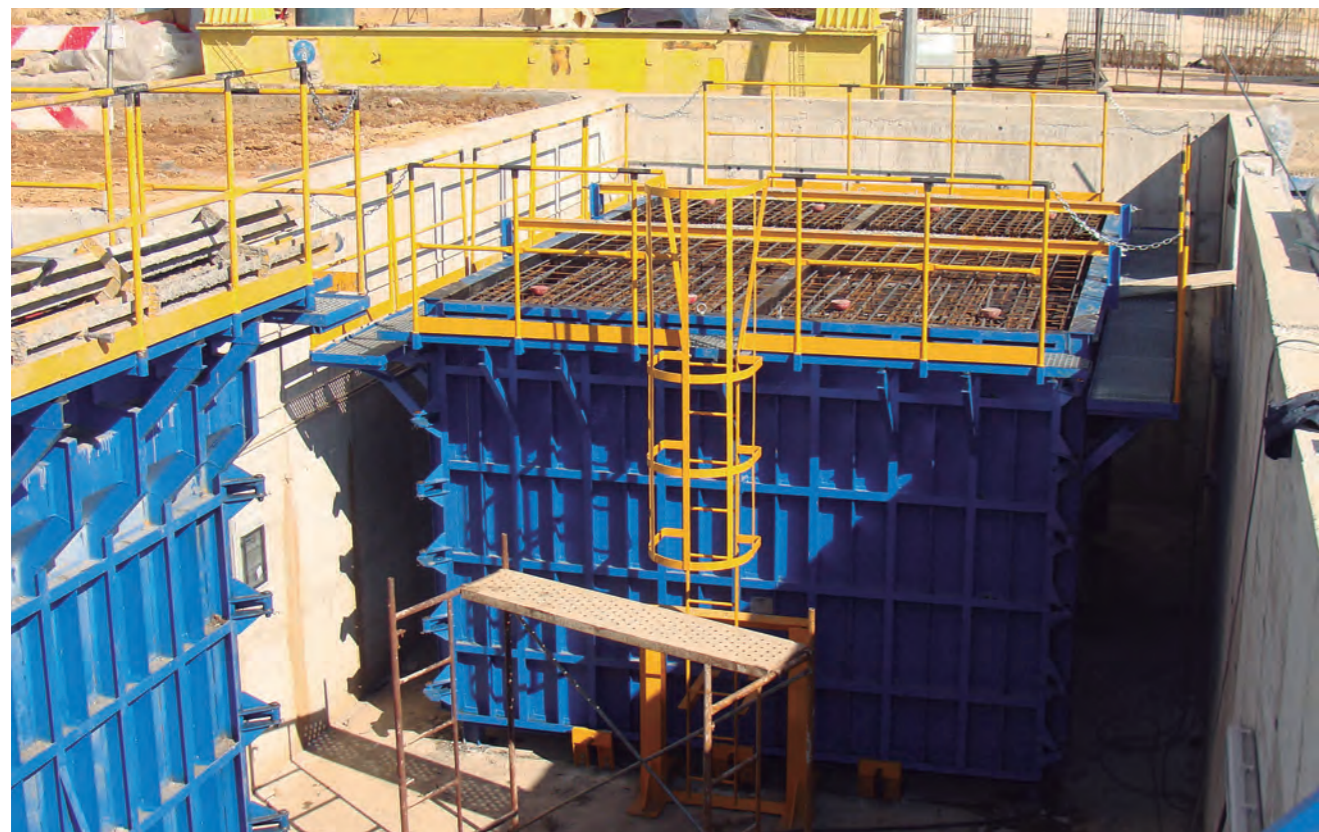
Colocación de semi-marcos para un paso inferior de autopista
