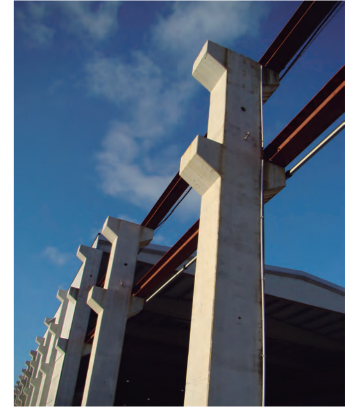
Columnas con 4 ménsulas
