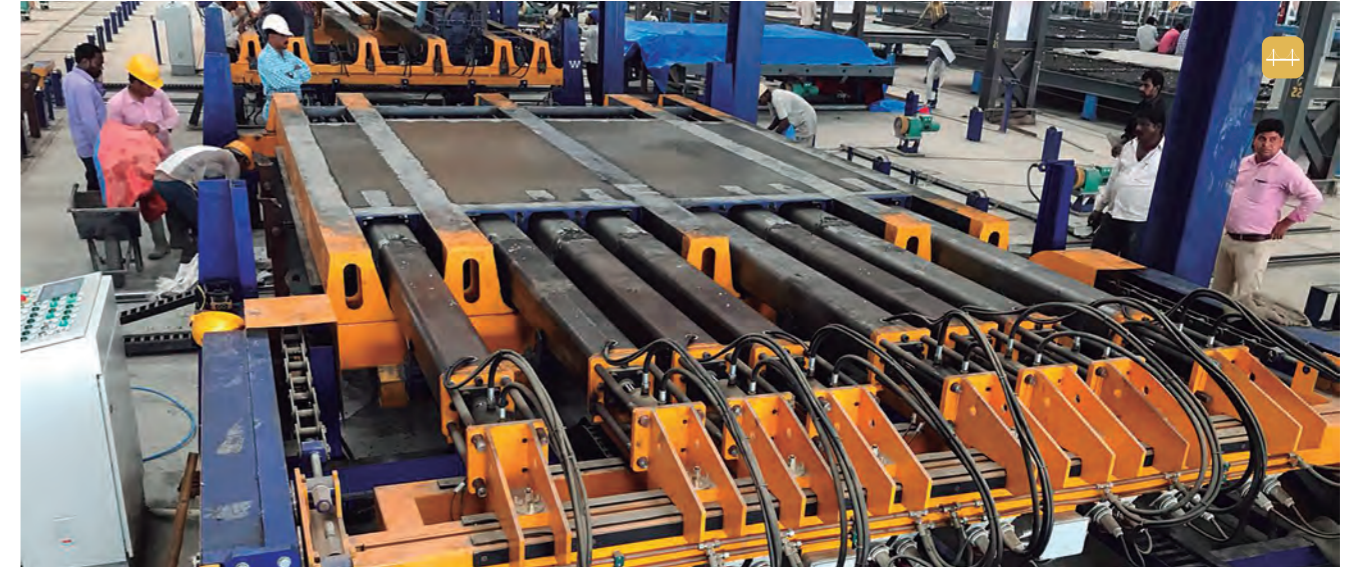
Moldes listos para desmoldeo
