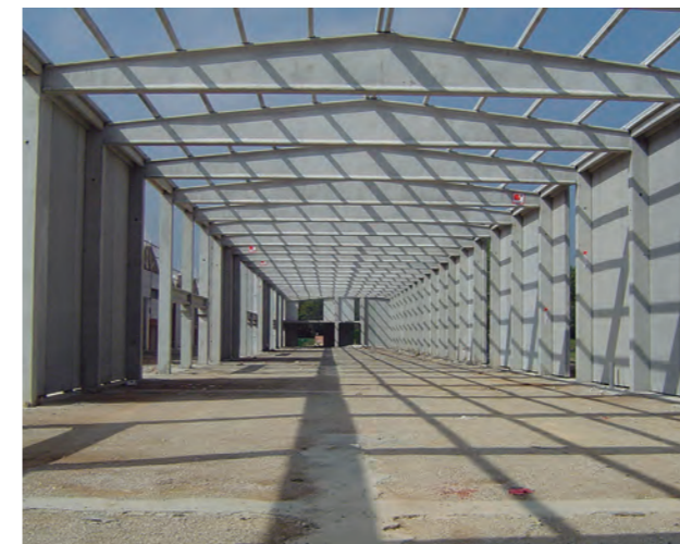
Edificio industrial con correas sobre viga delta
