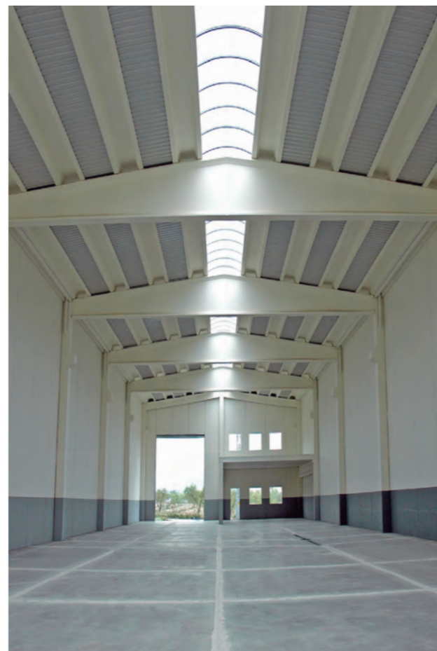
Edificio industrial con vigas delta y placas de cubierta
