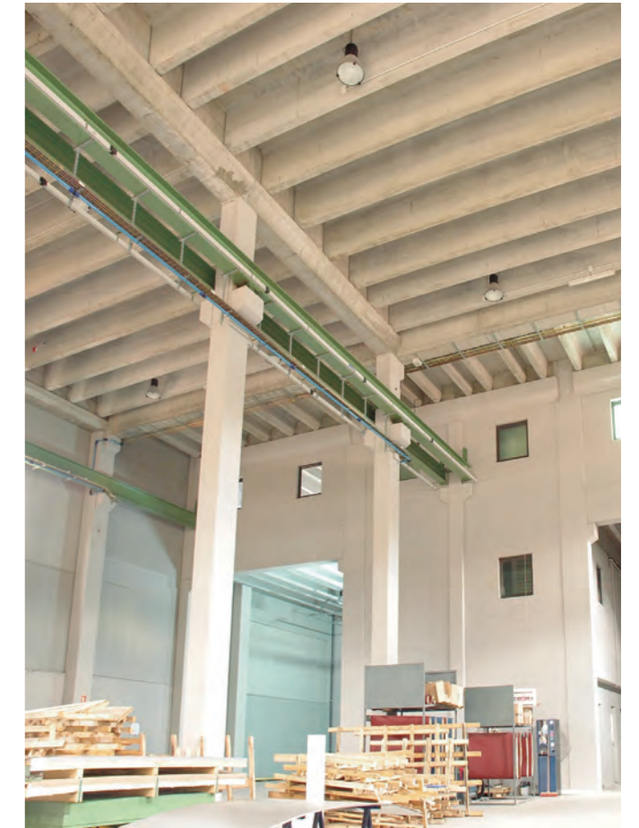
Nave industrial con placa TT para cubierta
