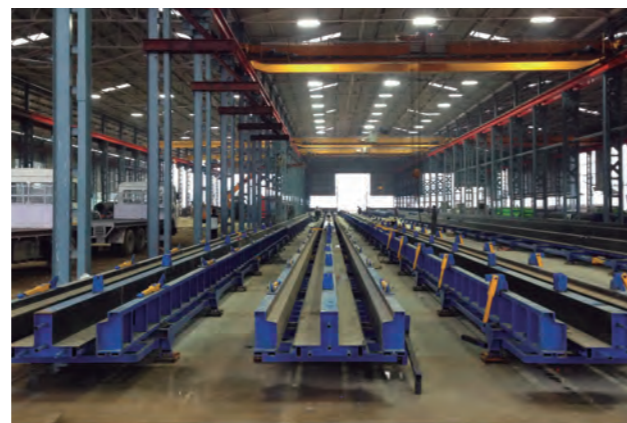
India: instalación completa de más de 2km de moldes, para la producción de vigas prefabricadas para proyectos de viviendas
