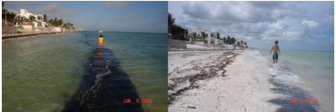
Figura 74. Ejemplo de instalación de un sistema geotextil como rompeolas sumergido y desvinculado de la costa en Yucatán, México. Perfil de playa acumulado entre junio de 2005 (izq) y julio de 2006 (der). Fuente: Álvarez et al. (2007).
