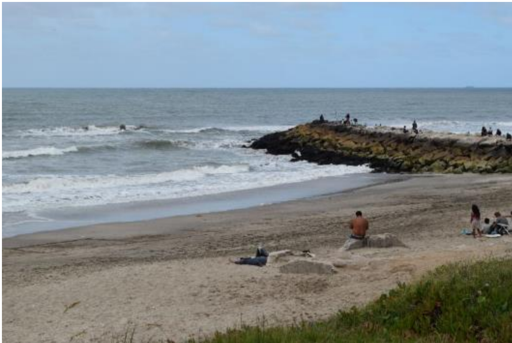
Figura 50. Escollera ubicada en el sector norte de Miramar, Partido de General Alvarado.
