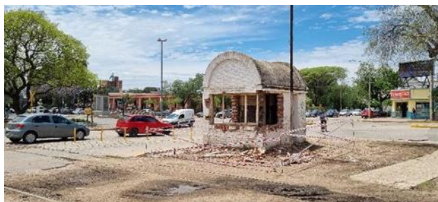
Imagen N.º 6.22: Garita de paso a nivel. Calles Julio A. Roca y Av. Juan B. Justo
