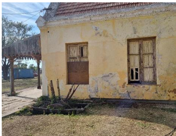
Imagen N.º 6.28: Vista lateral de Estación Sarmiento. Estado de conservación: Intermedio Fotografía del Autor – Fecha de toma: 22 de noviembre de 2022
