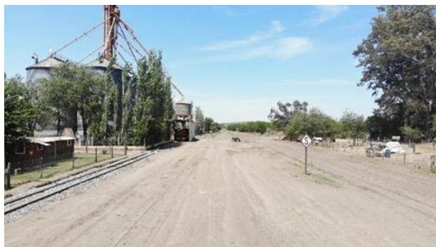
Imagen N.º 6.10: Estación Caroya y Silos de Carga con línea ferroviaria anexada
