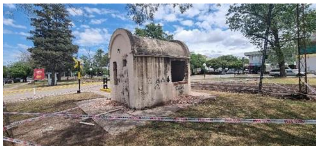
Imagen N.º 6.21: Garita de paso a nivel. Calles Chile y Av. Juan B. Justo
