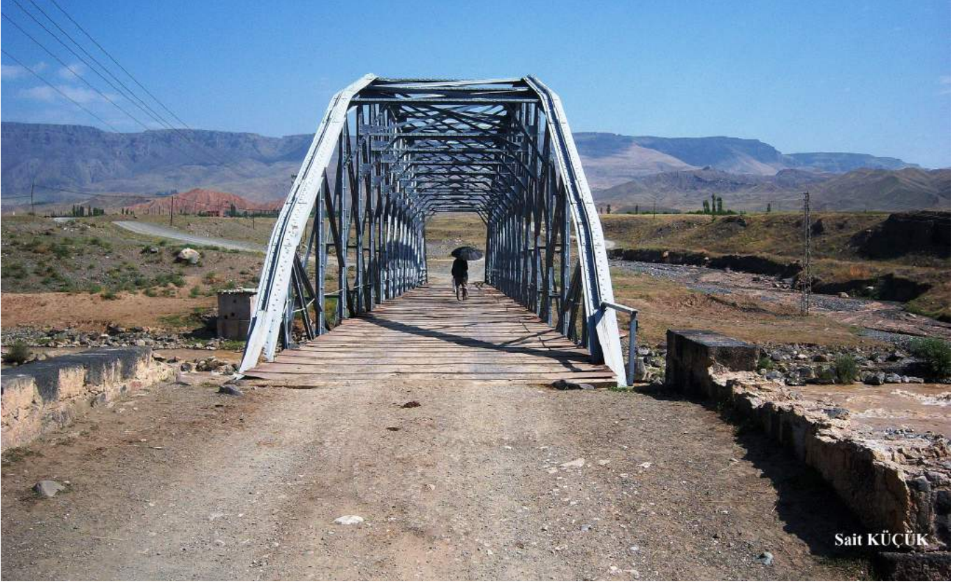
Aras Nehri ve Demirköprü
