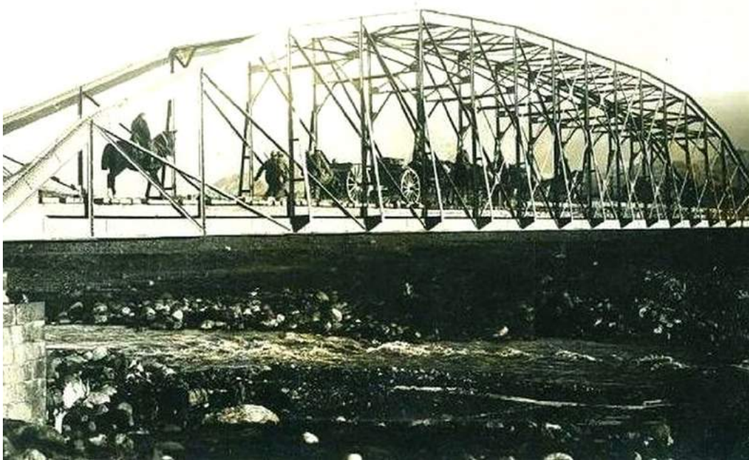
Aras Nehri Demir Köprü
