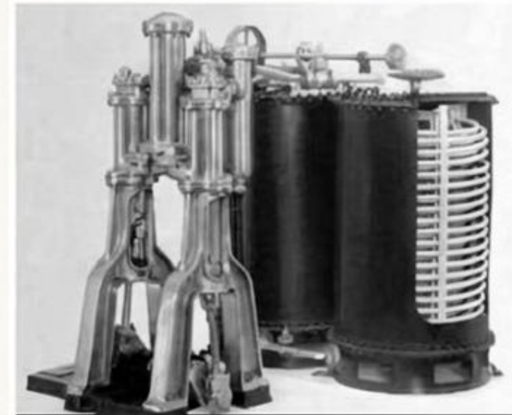
De Linde ammoniak koeler werd in 1877 voor het eerst in gebruik genomen door de Dreher Brouwerij in Triëste.
