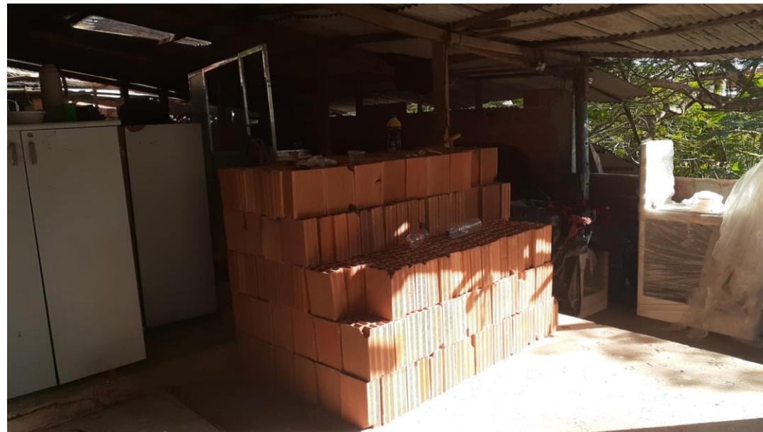
Blocos do Banheiro
