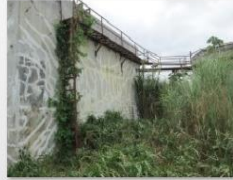
3. Estado inicial de reactores
