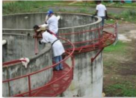
10. Rehabilitación y Pintura de plataforma
