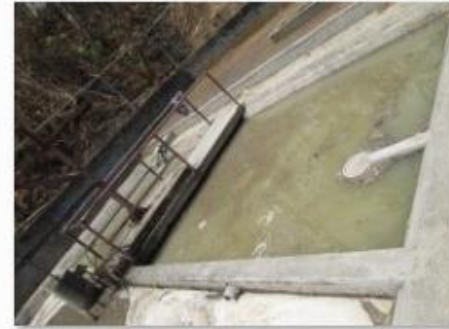
11 Estado Final Desarenador
