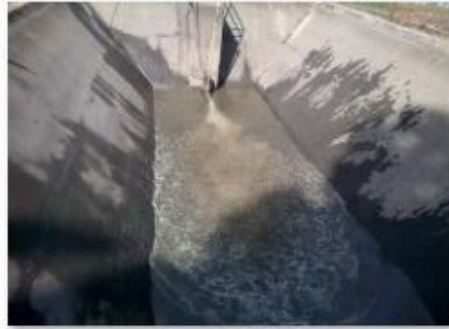
10 Estado Final Desarenador
