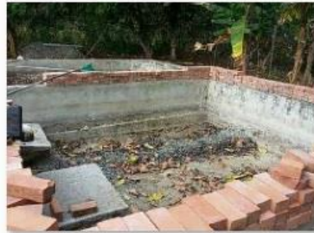
6 Rehabilitacion Lecho Secado 1
