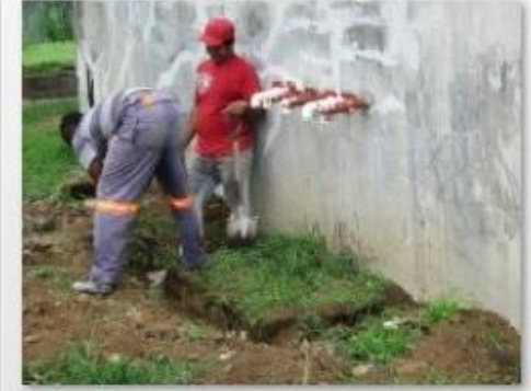
4. Elaboracion tanque pruebas de lodos
