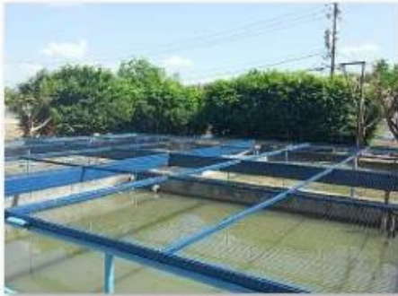
5 Pintura e Instalacion Malla Reactor
