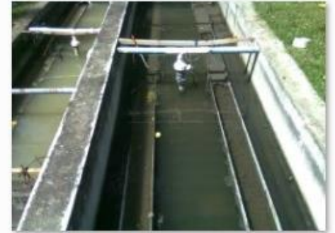
12 Estado Inicial Sedimentador
