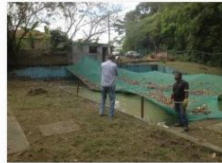
15 Estado Inicial Reactor
