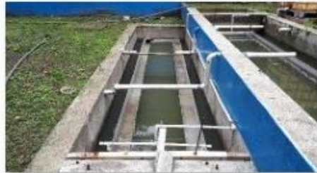
14 Estado Final Sedimentador
