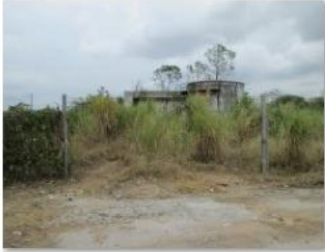
1. Estado inicial de la planta
