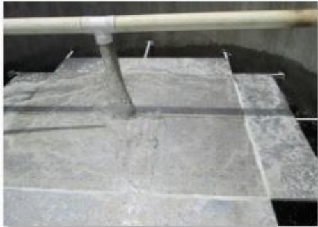
13. Rehabilitación de biofiltros.
