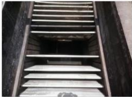
13 Estado Inicial Sedimentador
