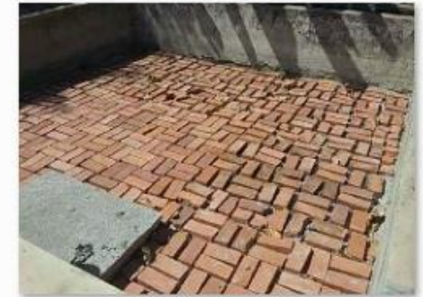
8 Rehabilitacion Lecho Secado 3
