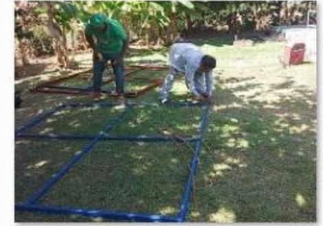
4 Pintura e Instalacion Malla Reactor 1
