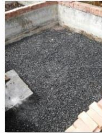
7 Rehabilitacion Lecho Secado 2
