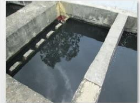
8. Limpieza del efluente en el reactor
