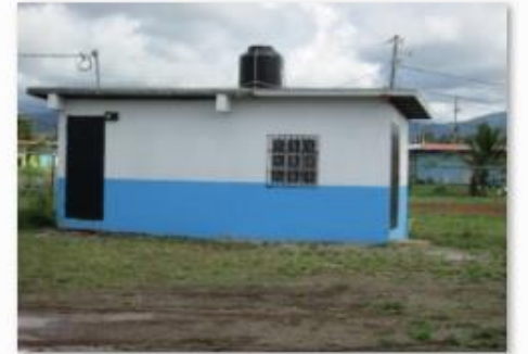
16 Estado final de caseta de controles y vigilancia
