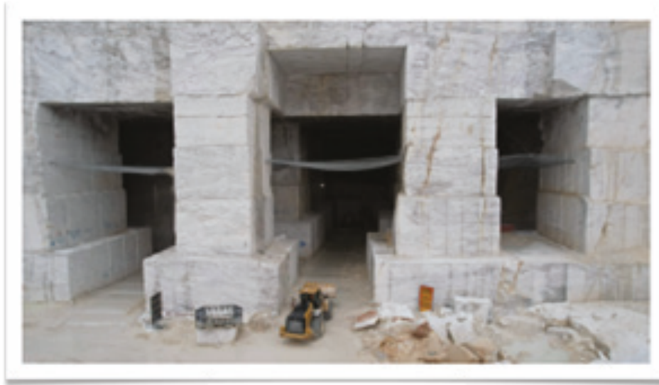
Fig. 2. Entrances of underground marble quarry., implementing room & pillar mining method. Şekil 2. Yeraltı mermer ocağının girişleri, oda ve sütun madenciliği yöntemi uygulanarak.
