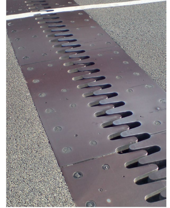
Köprü genleşme bağlantıları
