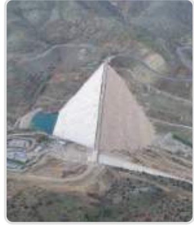
Görsel 2.1: Konya Bozkır Barajı gövdesi
