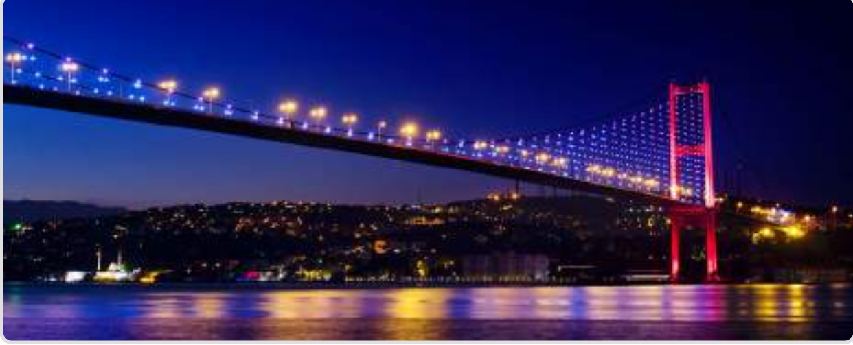
Görsel 1.1: 15 Temmuz Şehitler Köprüsü
