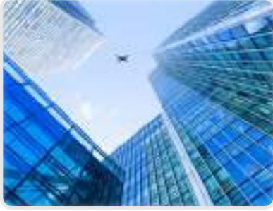
Görsel 4.7: Dış cephesi ayna olan binalar
