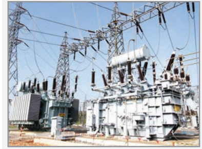
Resim 2.20: Transformatör
